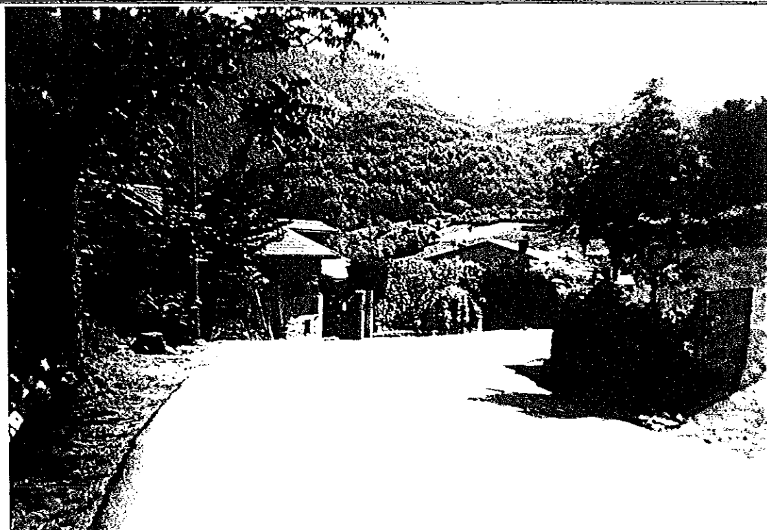
ZONA DI COMPLETAMENTO (ZONAB2) A RIDOSSO DEL CENTRO STORICO
